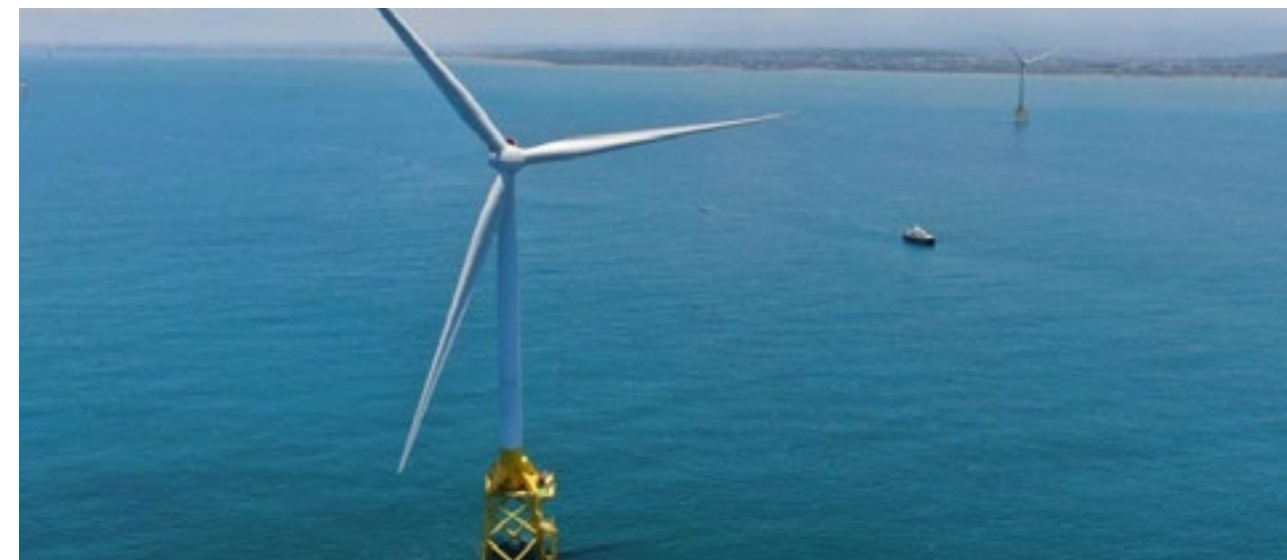
Formosa II, projet éolien en mer Infrastructures | Asie-Pacifique | Partenaire : Stonepeak
