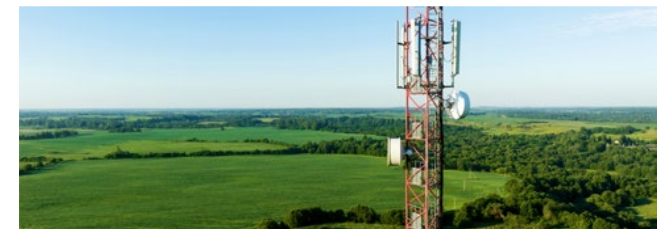
Vantage Towers, tours de télécommunications Infrastructures | Europe | Partenaire : Global Infrastructure Partners
